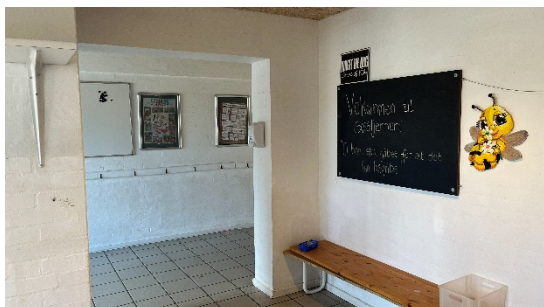
Garderobe i tilbygning
