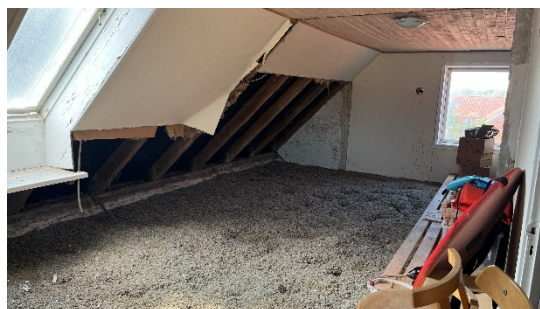
Isolering på tagetage
