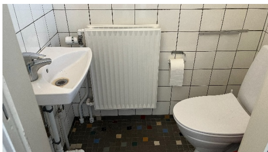
Voksen-/personalettoilet i oprindelig bygning.
