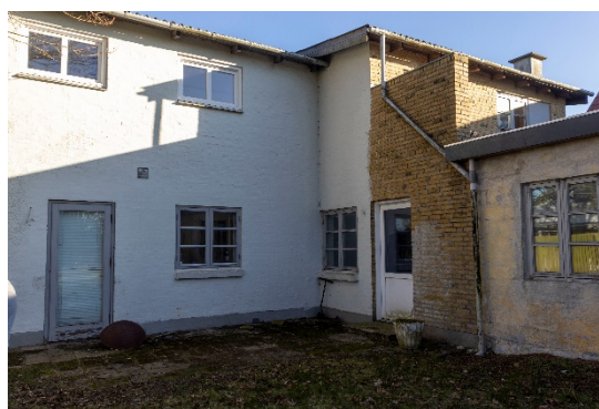
Taget fra vest med vinduer mod køkken, indgangsparti og badeværelse samt døre i bryggers/viktualierum og indgangsparti
