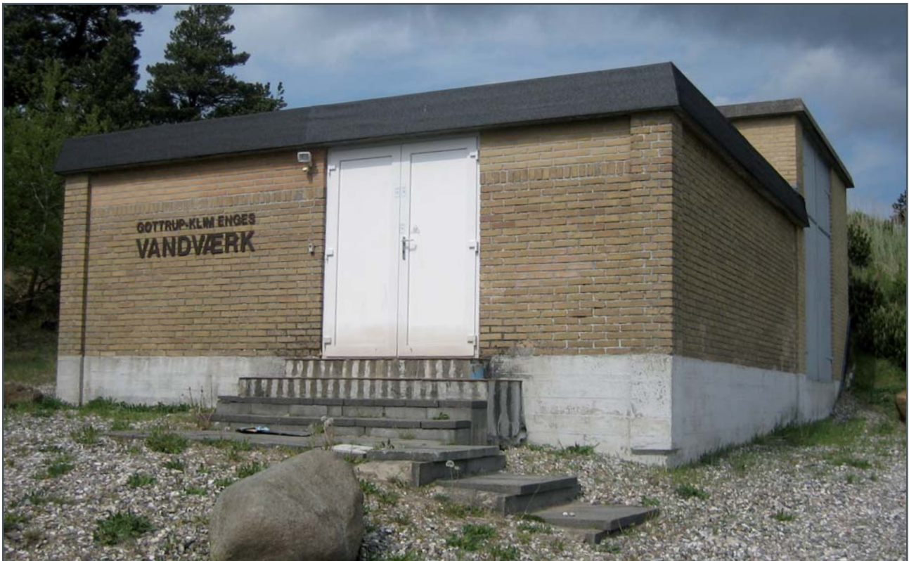
Gøttrup Klim Enges Vandværk
