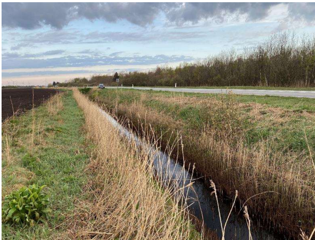
Figur 56. Position 2. Grøften langs Blokhusvej set mod vest afvander en større del af Store Vildmose og der er en kraftig vandføring.
