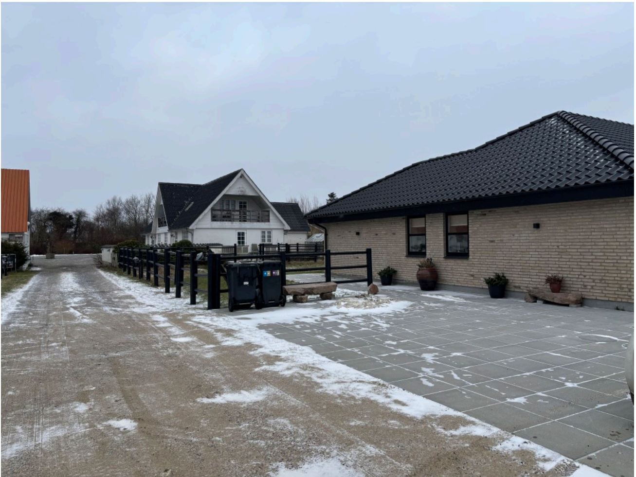
Forrest i billedet er det nyopførte parcelhus i delområde II. Bag det ses det gamle stuehus og gavlen af landbrugsbygningen i lokalplanområdet.
