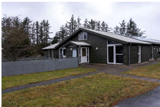
Administrationsbygningen fra sydøst
