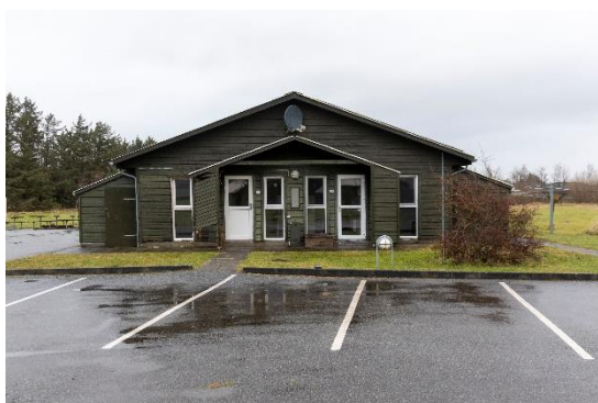
Et af beboelseshusene - hus 1-8 - udvendigt
