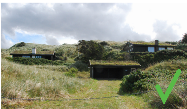
Indkørsel og parkering placeret lavere end sommerhus. Derved undgås terrænregulering og stejl indkørsel.
