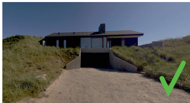
Kælder ikke synlig ud over indkørsel til garagen.
