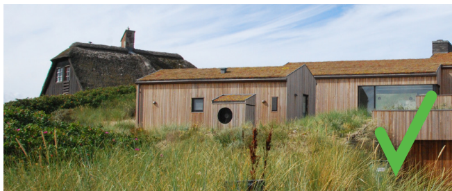
Varmepumpe godt integreret med boks på facaden.
