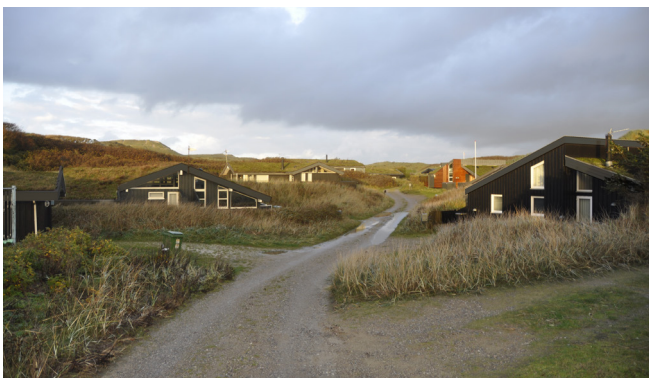
Sterne og vindskeder i samme farve som sommerhuset gør dem mindre markante og dominerende.
