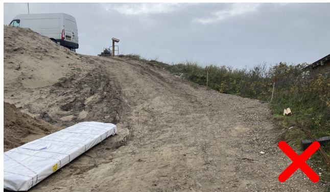
Stejl indkørsel og terrænregulering på mere end \pm 0,5 m er ikke ønskeligt.
