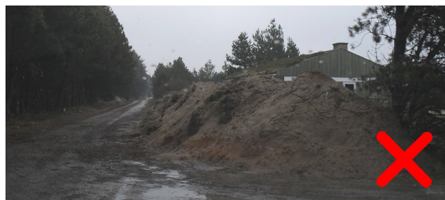
Nyetableret jordvold over 0,5 m etableret som hegn mod vej. Jordvolden tillades ikke i sommerhusområdet.
