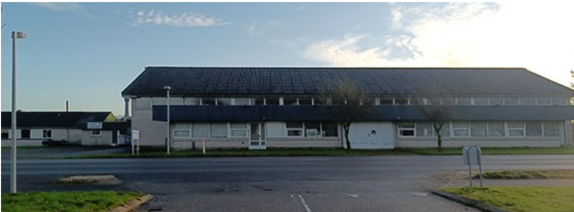
Lige overfor Sundhedshuset i erhvervsområdet ligger en bygning med kontorer og lagerfaciliteter.
