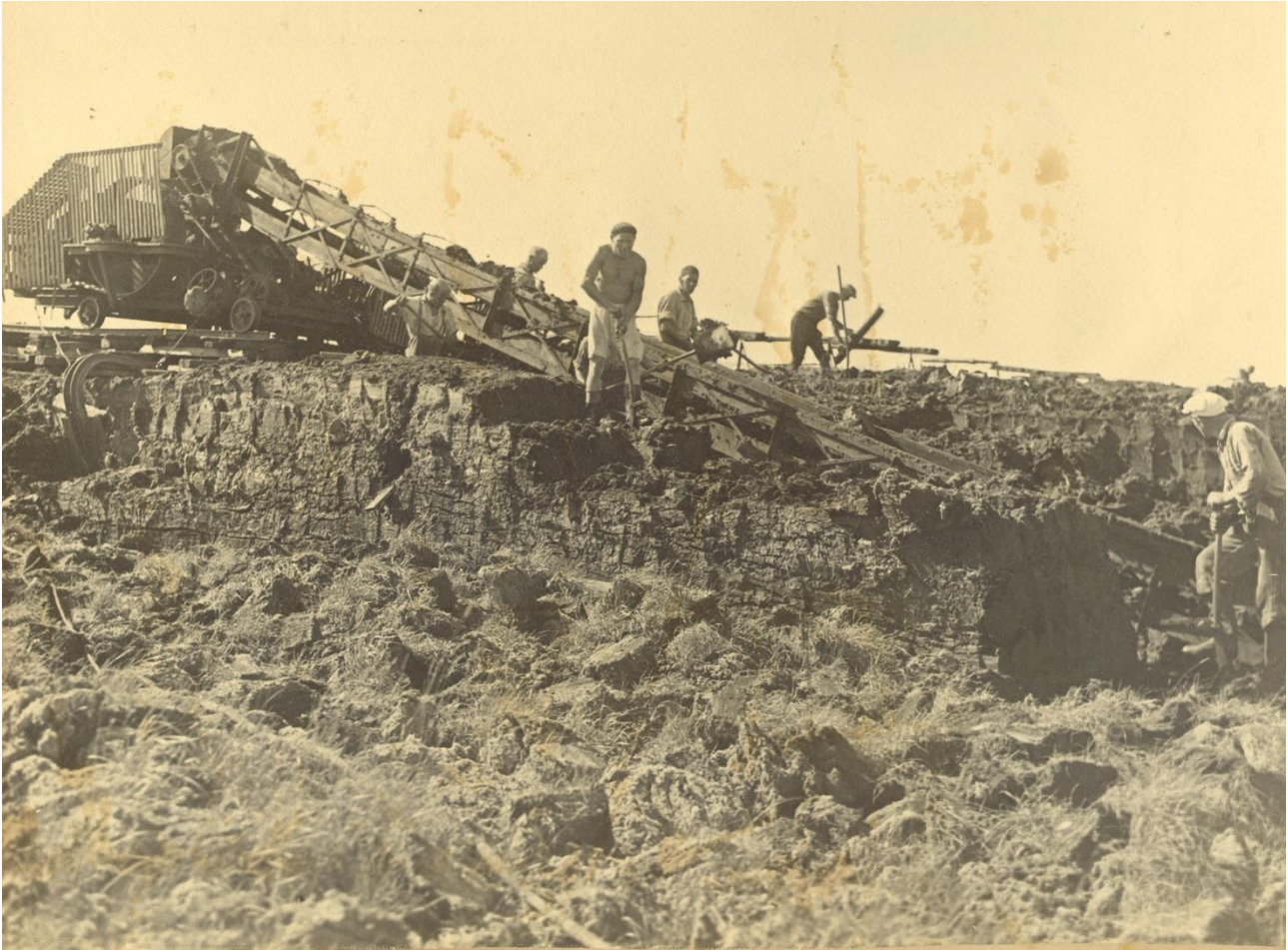
Tørvegravning i Store Vildmose i 1940'erne. Arbejderne udstikker tørvestykker som lægges på transportbåndet, der løfter tørvene op af tørvegraven.
