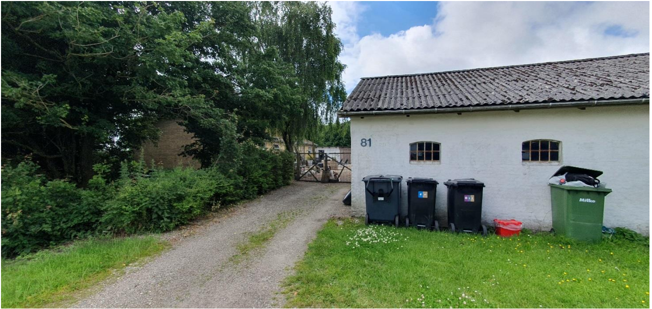
Tueengvej 81 er et nedlagt landbrug med stort areal af udbygninger.
