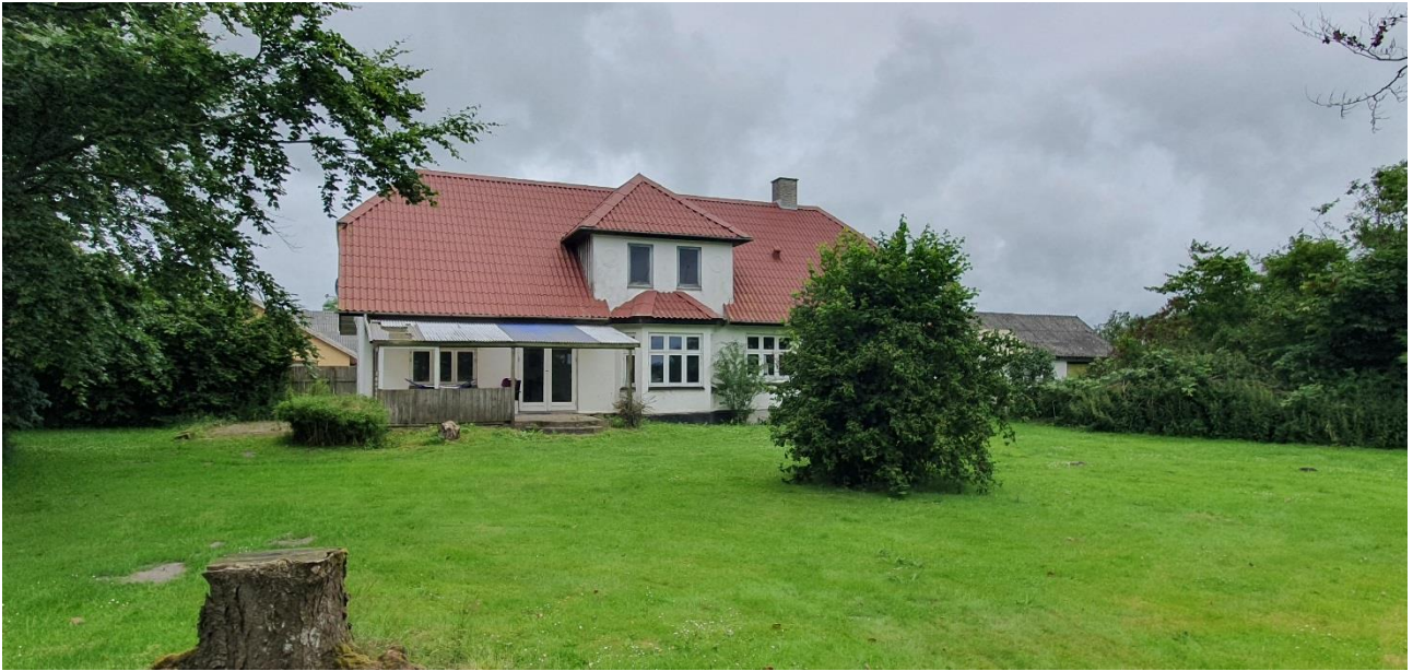
Stuehuset på Tueengvej 50. Især taget over karnappen er meget åbent nedefra, men der blev ikke set tegn på flagermus under inspektionen.
