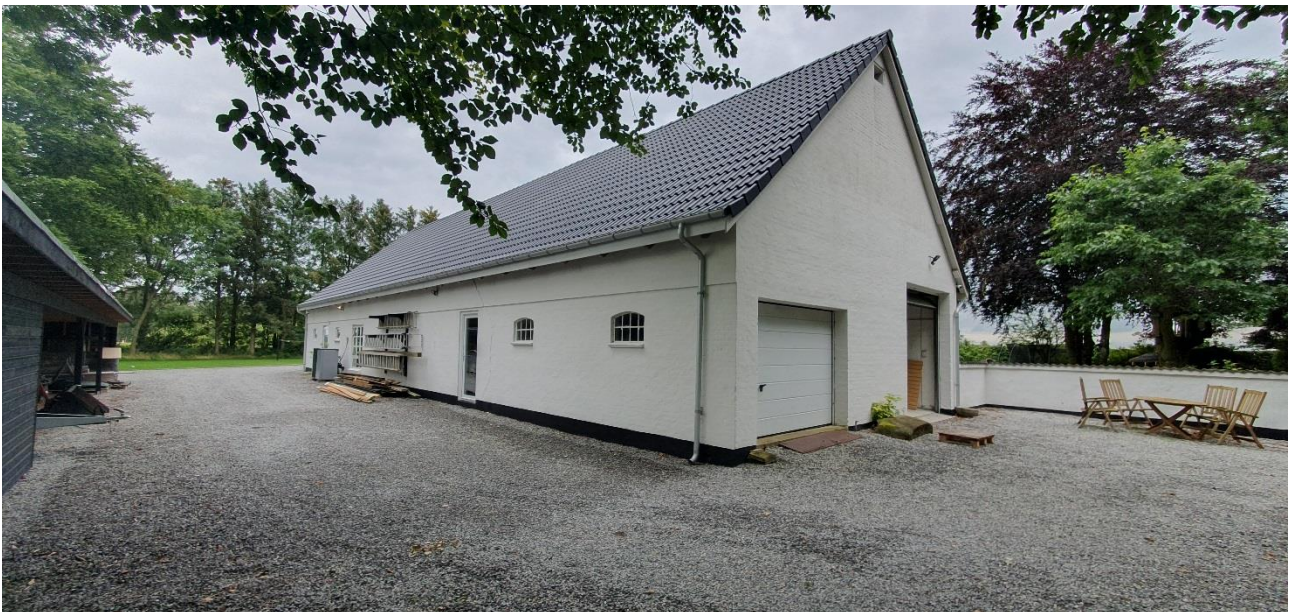
Murværk og tag helt nye tage på Toftegårdsvej 131 viste ingen spor efter flagermus.
