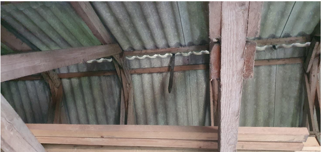
Åbne undertag med få skjulesteder på en større tagflade på Tueengvej 81 indbyder ikke til flagermus. Ved den visuelle kontrol blev der heller ikke fundet spor efter flagermus inde i bygningerne.
