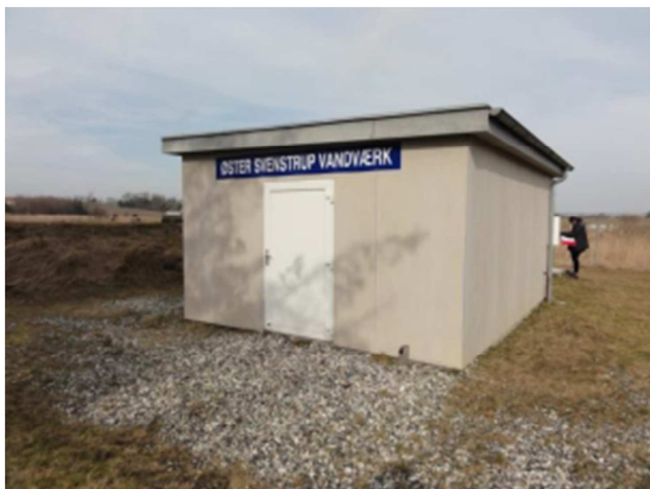
Figur 38-1 Øster Svenstrup Vandværk (Jammerbugt Kommune, 2012)
