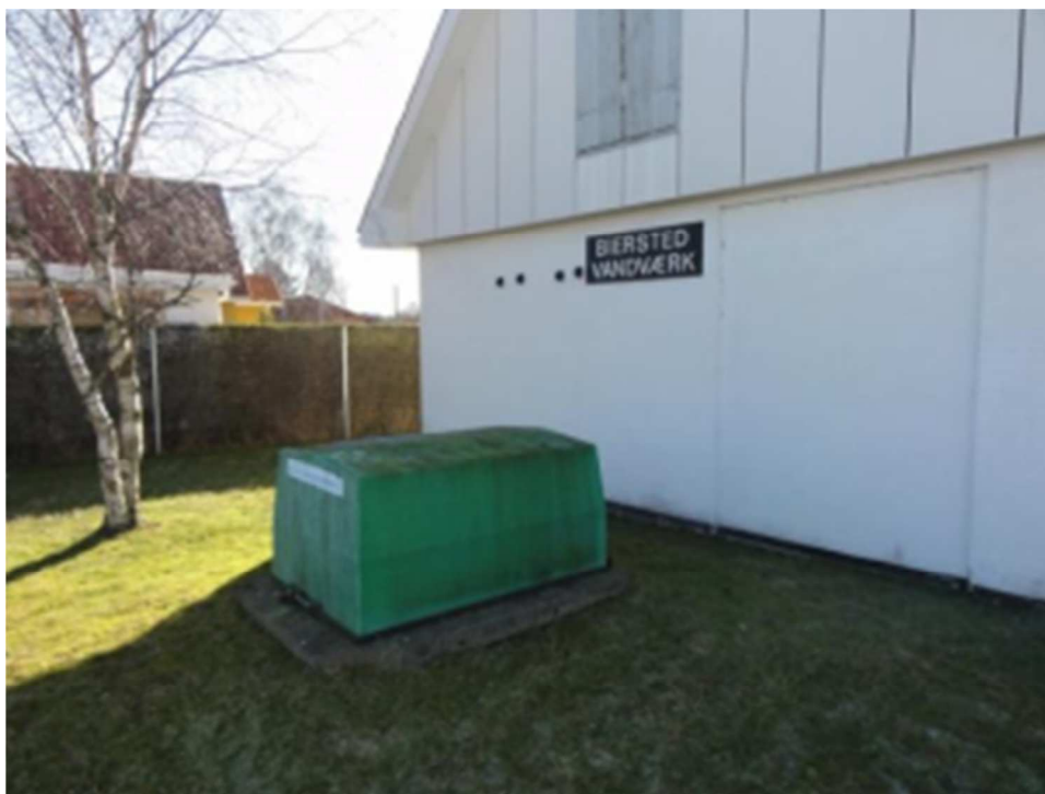
Figur 4-1 Biersted Vandværk (Jammerbugt Kommune, 2012)
