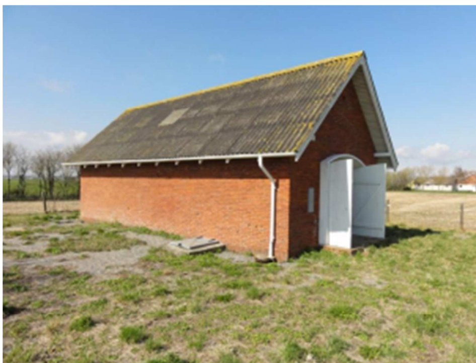
Figur 18-1 Hvolgård Vandværk (Jammerbugt Kommune, 2012)
