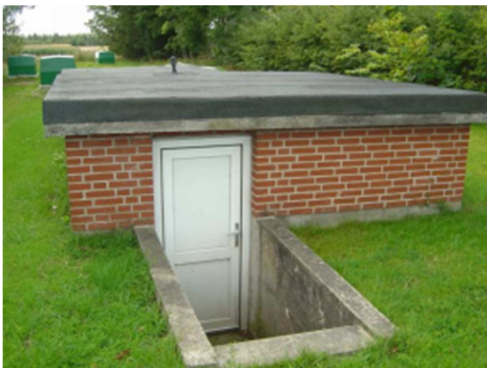
Figur 22-1 Kaas Mark Vandværk (Jammerbugt Kommune, 2012)
