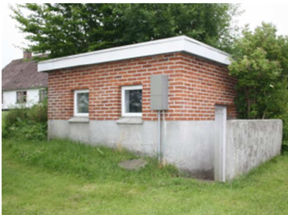
Figur 11-1 Gjøl Nørredige Vandværk (Jammerbugt Kommune, 2012)
