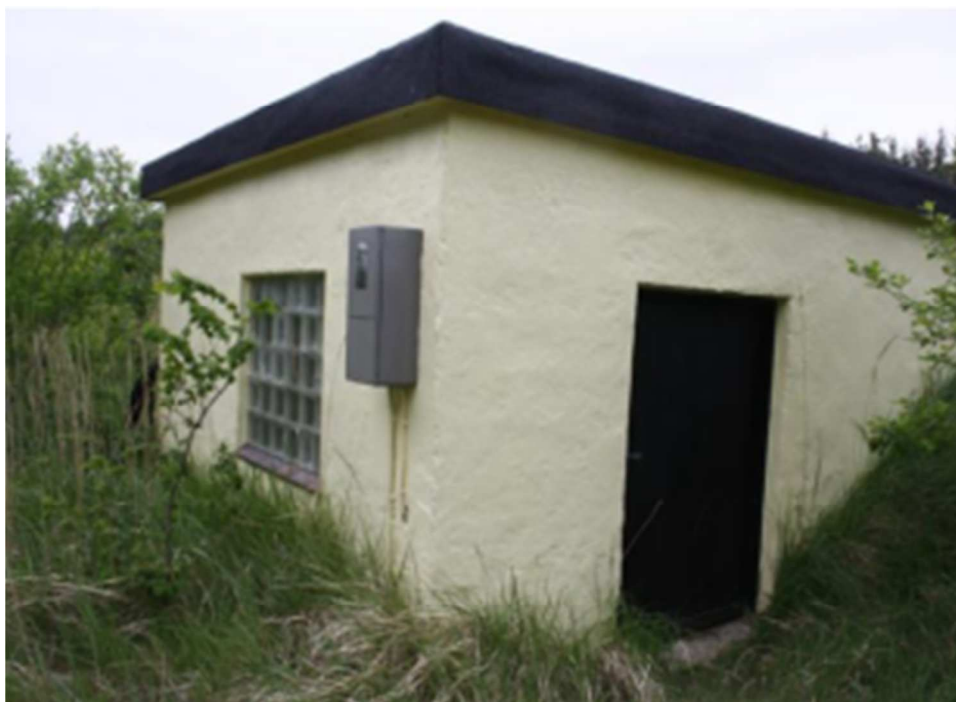
Figur 33-1 Svinkløv Vandværk (Jammerbugt Kommune, 2012)
