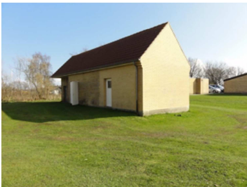
Figur 39-1 Østerby Vandværk (Jammerbugt Kommune, 2012)
