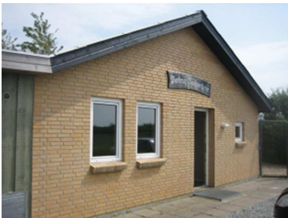
Figur 27-1 Pandrup Vandværk (Jammerbugt Kommune, 2012)
