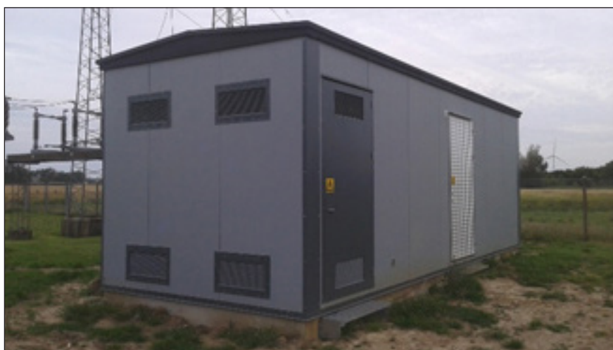
Figur 5. Eksempel på udformning af teknikbygning ved transformerstation.
