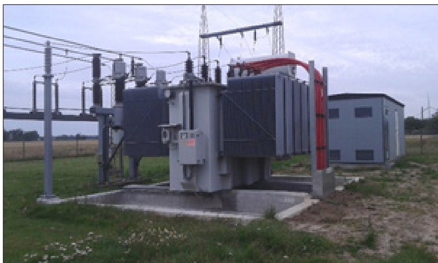
Figur 4. Eksempel på udformning af 60/10 kV transformer.
