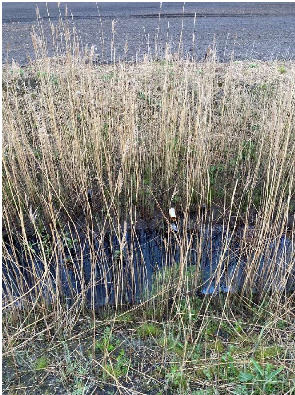
Figur 68. Position 8. Drænrør munder ud i grøften.
