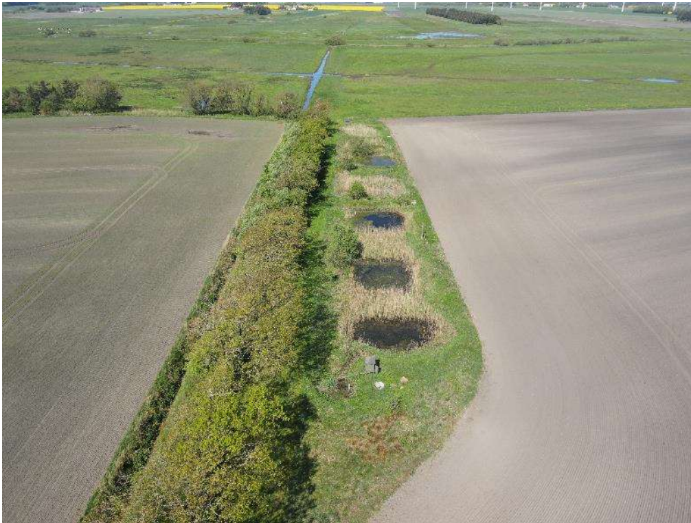
Figur 33. Vandhul C er anlagt for at rense drænvand og består af 6-7 vandhuller der er indbyrdes forbundne og vandet oppumpes fra grøften.
