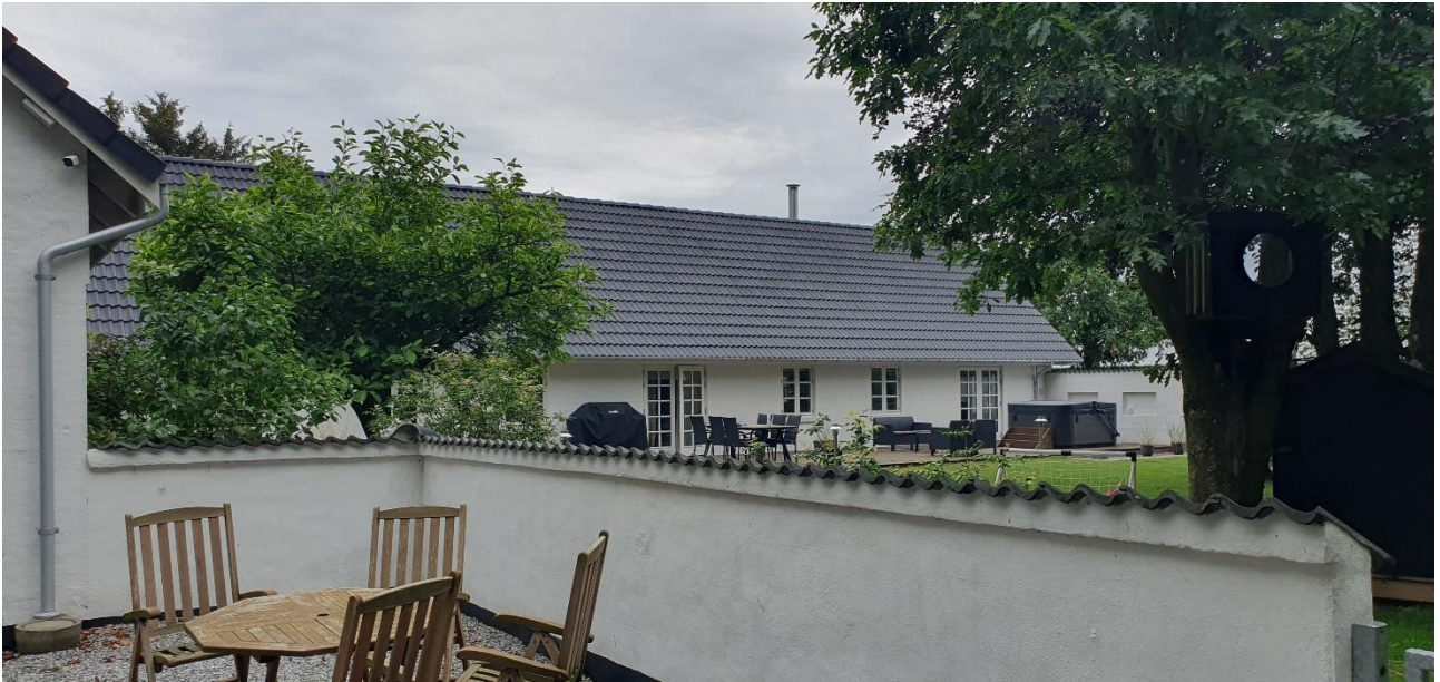
Der er nye helt tætte tage på Toftegårdsvej 131.
