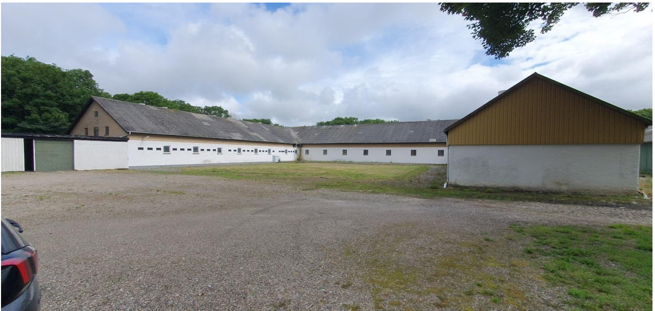
Aastrupvej 61 – der er et stort areal af stald og ladebygninger.
