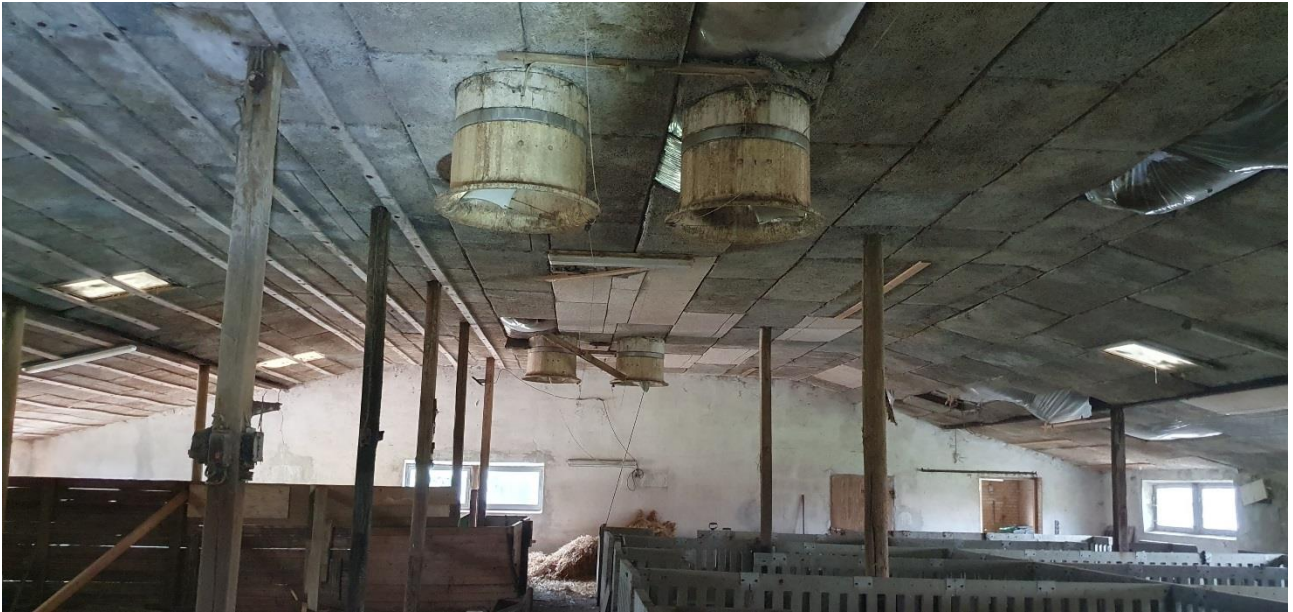
Staldbygning mod nord, Tueengvej 50. Det var kun muligt at kigge ind under det sænkede loft i staldbygningen gennem huller i konstruktionen, men fra disse punkter sås ingen tegn på at der skulle bo flagermus.
