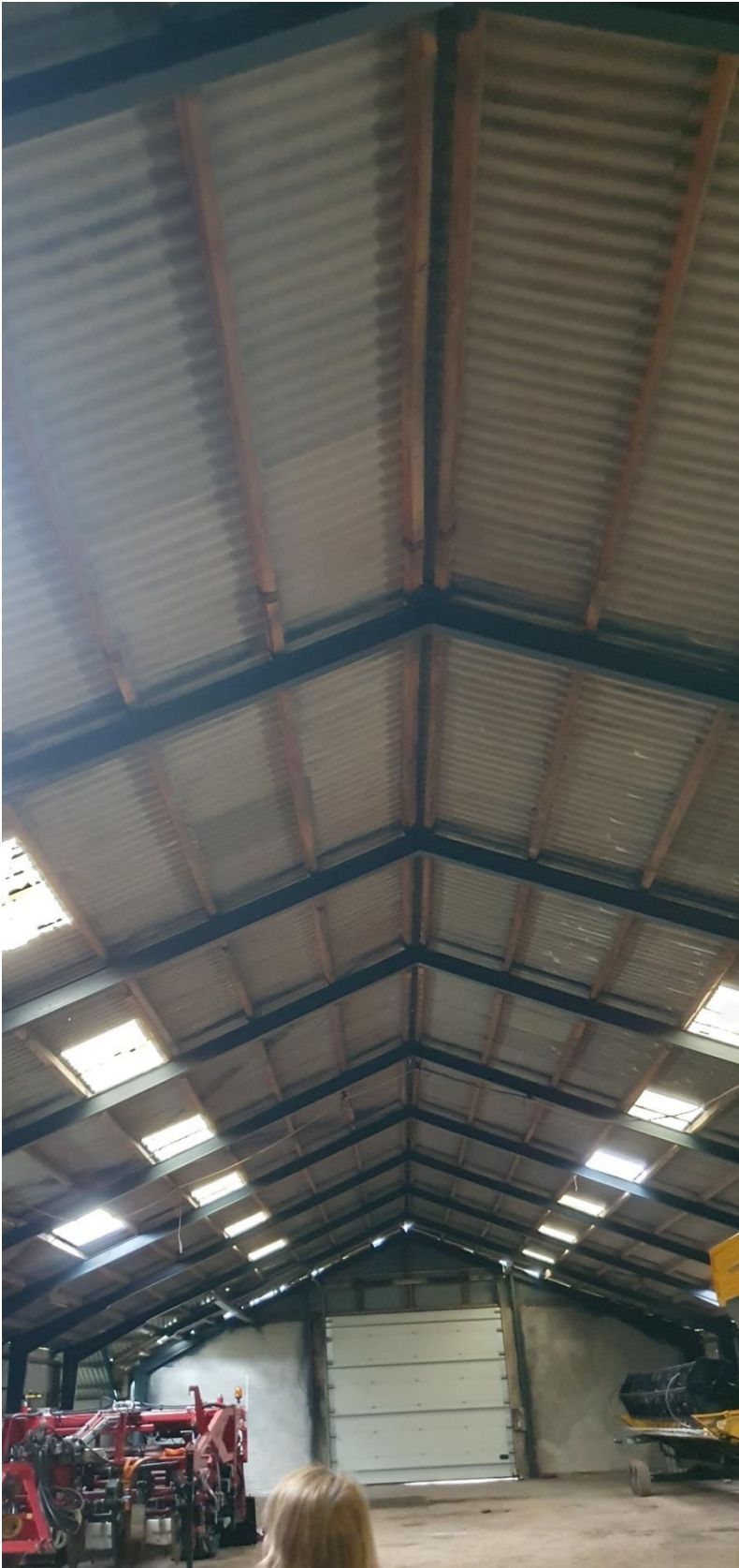
En stor maskinhal med stålbuer som bygningen mod vest på Tueengvej 50 rummer ingen potentielle levesteder for flagermus. Der blev ikke set flagermus eller spor af dem ved den visuelle inspektion.
