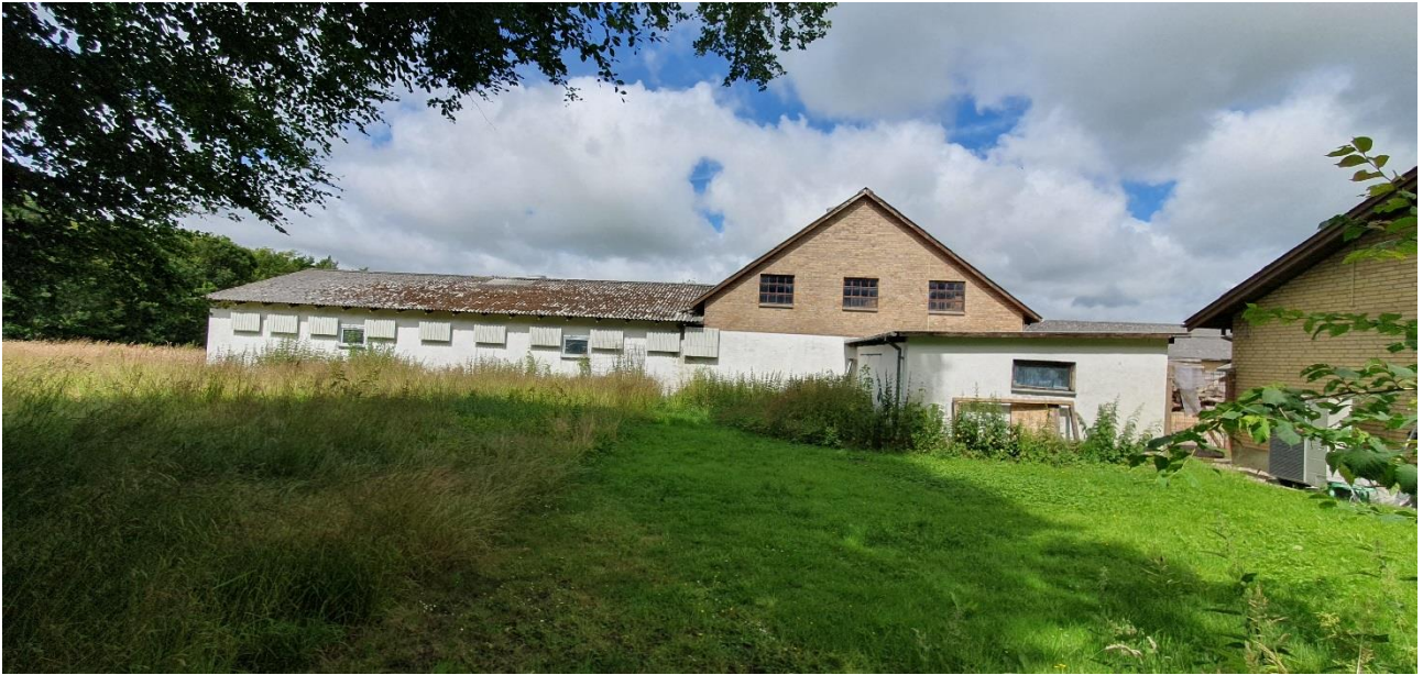
Tueengvej 81 – ved den visuelle inspektion af samtlige facader på ejendommen blev der ikke fundet klatter efter flagermus på murene.
