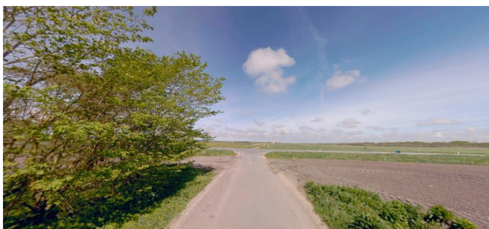
Figur 7-4 Gamle Toftegårdsvej i retning mod Blokhusevej. Kilde: Danmarks Digitale Gedefoto.
