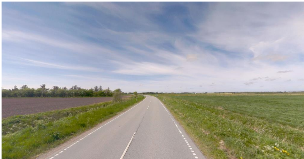
Figur 7-5 Blokhusvej i retning mod Gamle Toftegårdsvej. Kilde: Danmarks Digitale Gadefoto.
