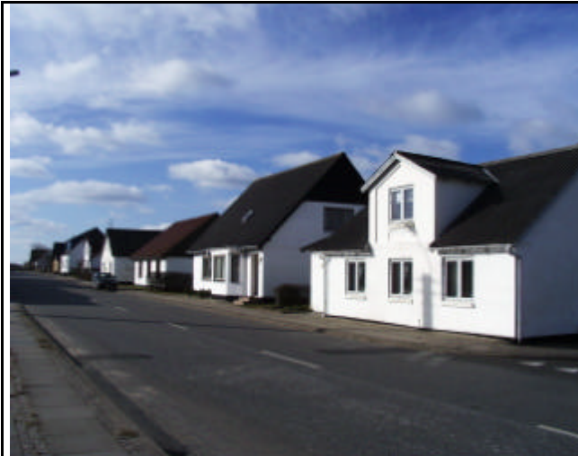
Eksempel på en række huse på Hovedgaden, hvor den oprindelige byggestil stort set er bevaret og taghældningen ligger mellem 40 og 50 grader.
